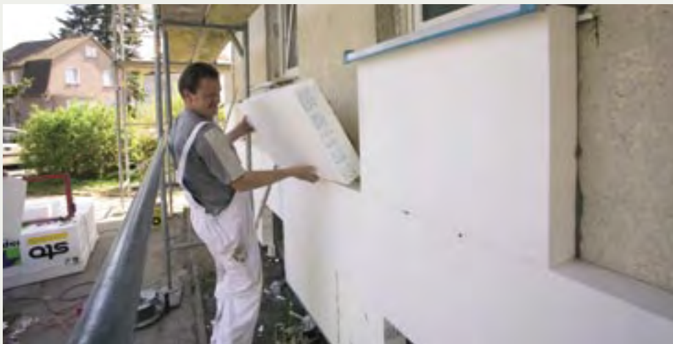
Wärmedämmung im Bestand
