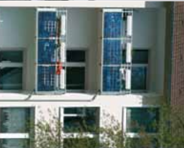
Balkone mit Photovoltaik- Elementen zur Stromgewinnung
